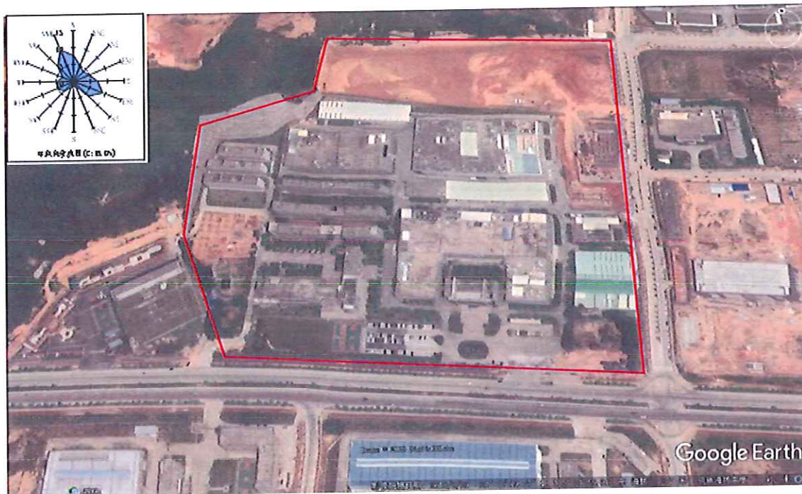
图 2.2-4 景旺电子科技（龙川）有限公司卫星影像图（2018 年 3 月 29 日拍摄）
