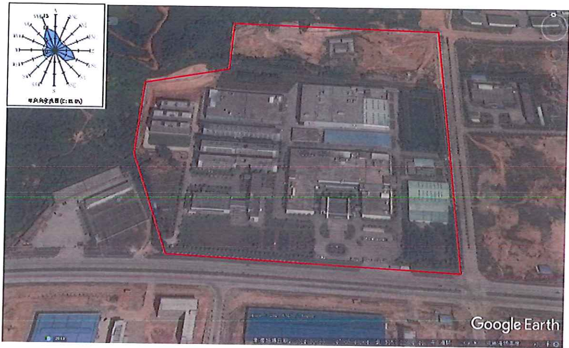
图 2.2-2 景旺电子科技（龙川）有限公司卫星影像图（2014 年 10 月 30 日拍摄）
