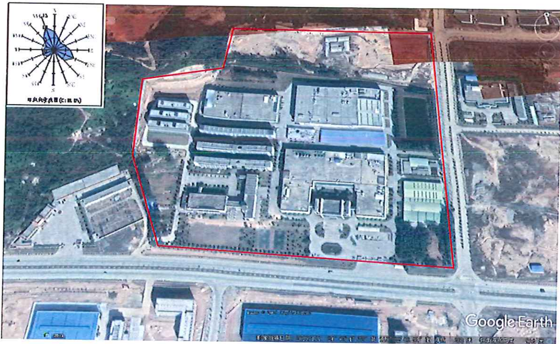
图 2.2-3 景旺电子科技（龙川）有限公司卫星影像图（2015 年 1 月 4 日拍摄）
